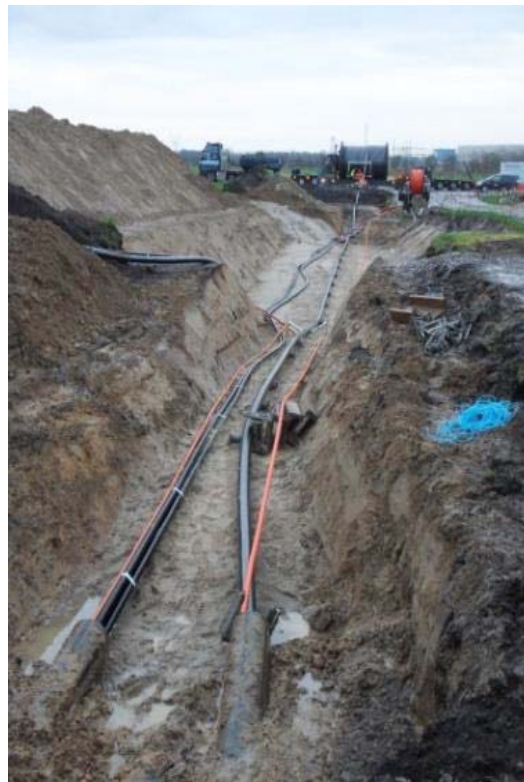
HDD-Bohrung und Muffengrube
