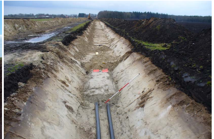
Schutzplatten + Trassenwarnband
