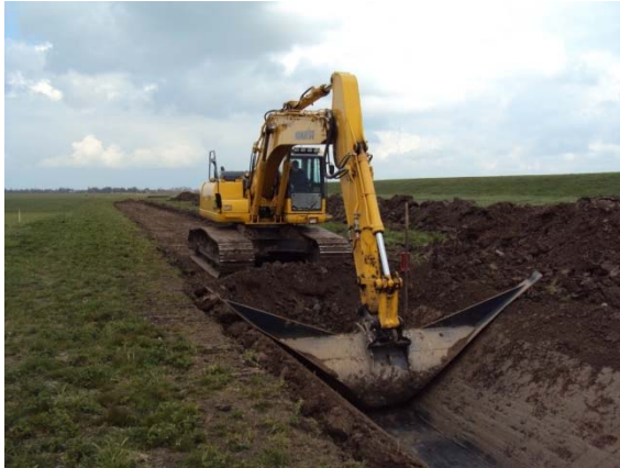
Bagger mit Profilschaufel 60°
