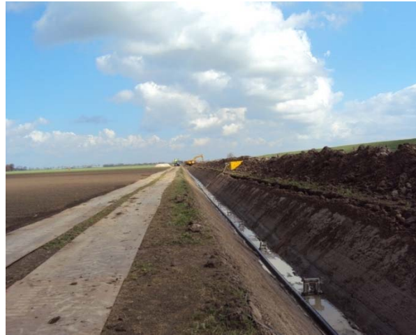
Zuwegung und Kabelgraben
