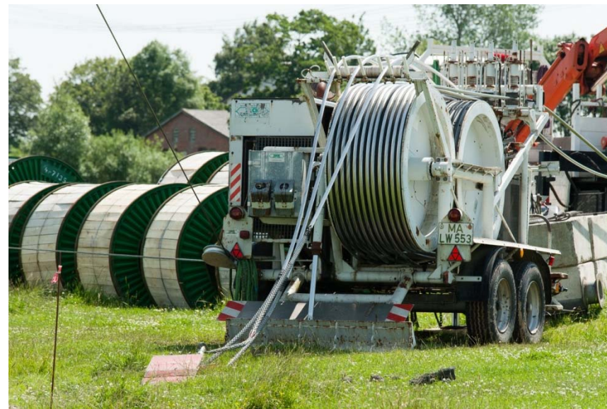
Seilbremse mit Leiterbündeln und Seiltrommeln
